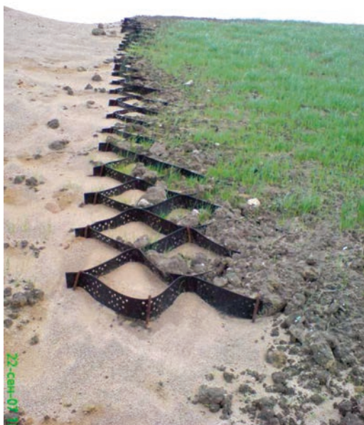
Рис. 3. Применение георешеток с целью объемного упрочнения грунта на склоновом участке (фото с сайта [10])
