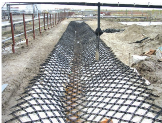
Рис. 11. Процесс сооружения водоотводной канавы с применением геосинтетических материалов (на этапе укладки георешетки). Фото из архивов ОАО «Фундаментпроект»
