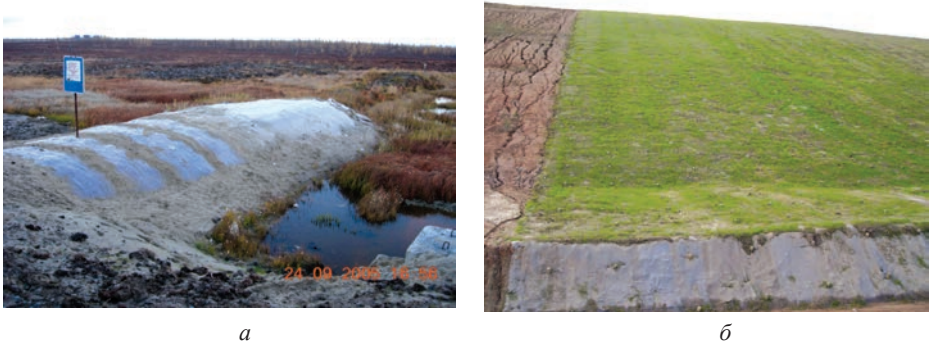
Рис. 2. Участки естественной поверхности, укрепленные при помощи биоматов: а — вид непосредственно уложенных на поверхность грунта «непроросших» полотнищ (фото В.Д. Кауркин, ОАО «Фундаментпроект»); б — растительный покров, сформированный «проросшими» полотнищами биомата (фото с сайта [6])
